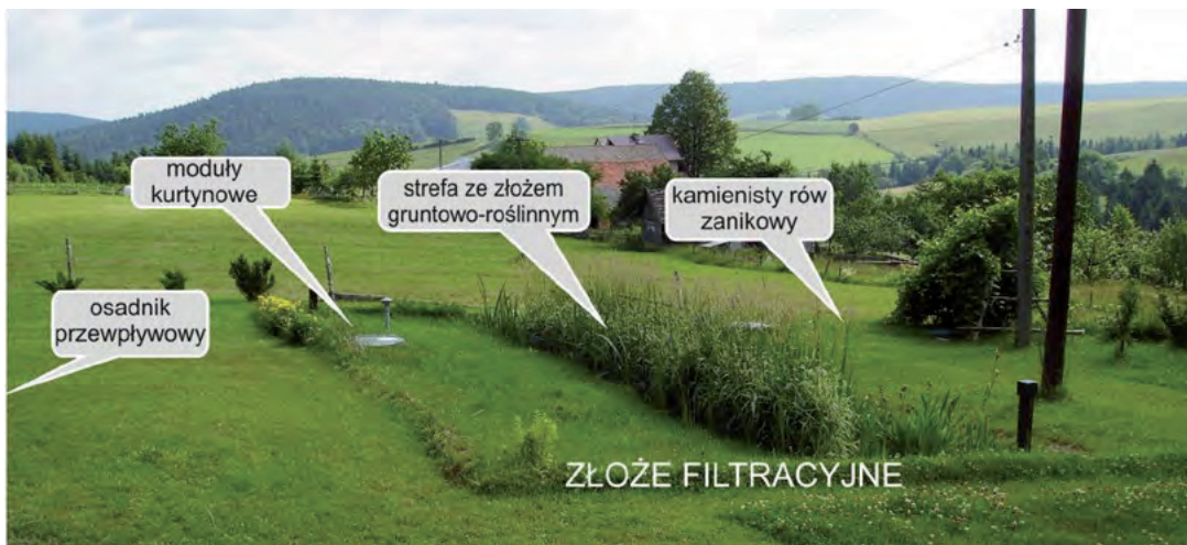
Fot. 7. Oczyszczalnia z zintegrowanym złożem filtracyjnym w gospodarstwie domowym zamieszkałym przez 5 osób
