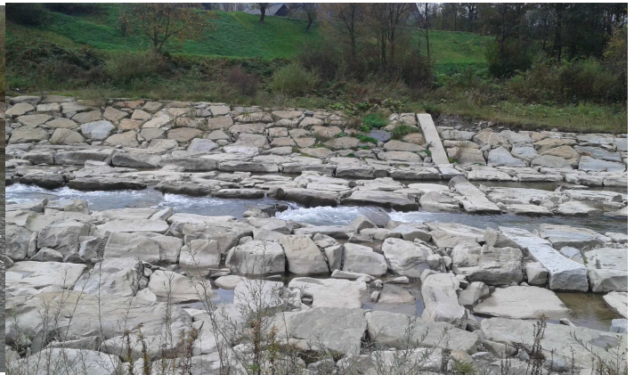
Pozytywny przykład spowolnienia rzeki—głazy umożliwiające bytowanie gatunków i kilka mniejszych progów, które ryby mogą pokonać, fot. PKE
