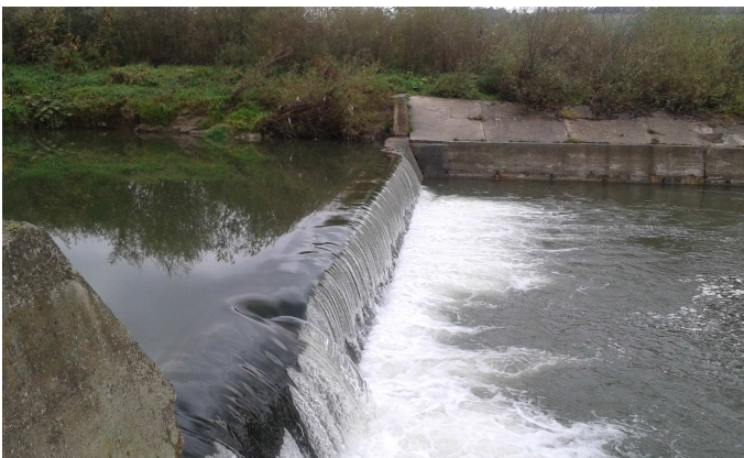
Negatywny przykład—niemożliwy do pokonania przez ryby betonowy próg, fot. PKE
