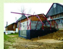
Budowa płyty gnojowej - wariant z zadaszeniem
