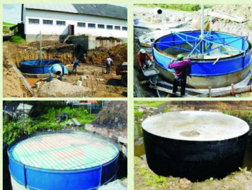
Budowa zbiorników na gnojówkę przy użyciu formy ślizgowej
