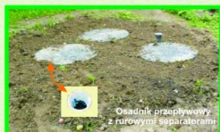
Osadnik przepływowy z rotacyjnymi separatorami
