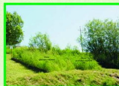
Złoże gruntowo-roślinne o przepływie poziomym
