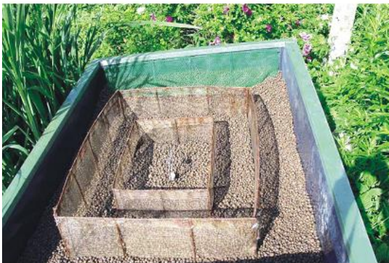
Rys.14. Złoże biologiczne o pionowym przepływie ścieków
