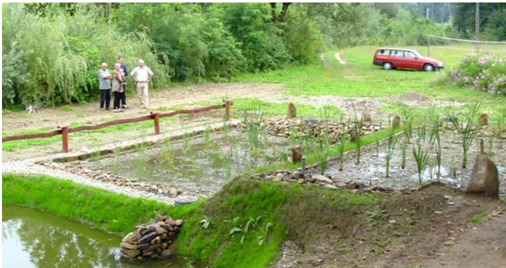
Rys.4. Oczyszczalnia roślinna po zakończeniu budowy.
